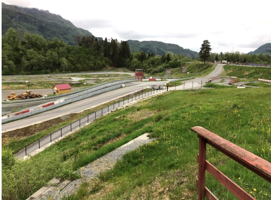
Nytt, flott gjerde på kanten av muren med ekstra høgde i svingen til sikring mot mulige objekter frå banen.
