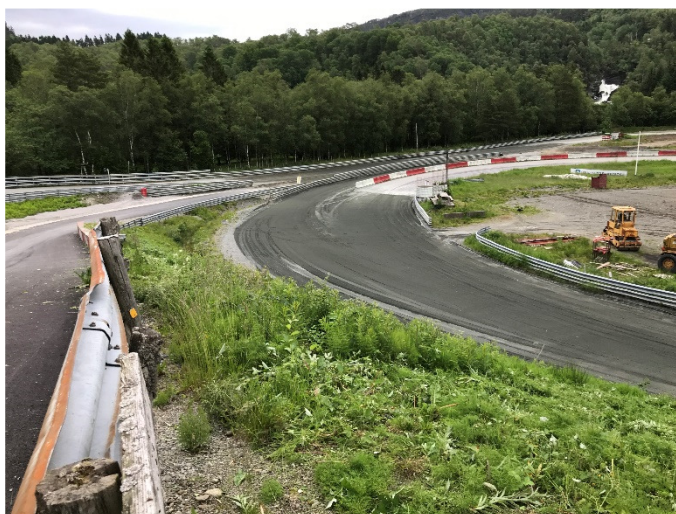
Bilde av det gamle rekkverket som no er bytta ut.
